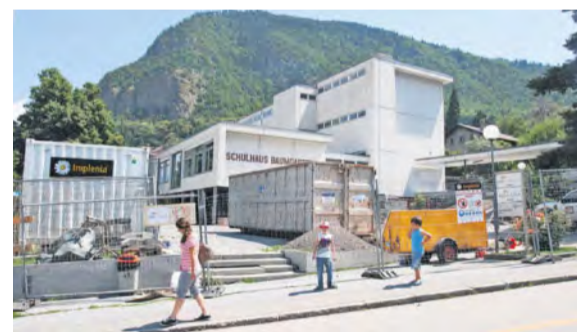
Zutritt verboten. Die Bauarbeiten beim Schulhaus Baumgärten West laufen bereits.
